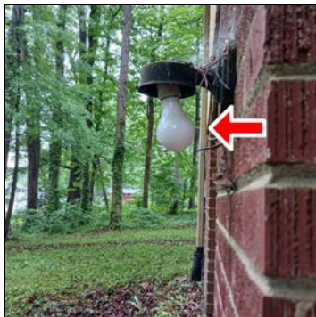
Basement entry door
